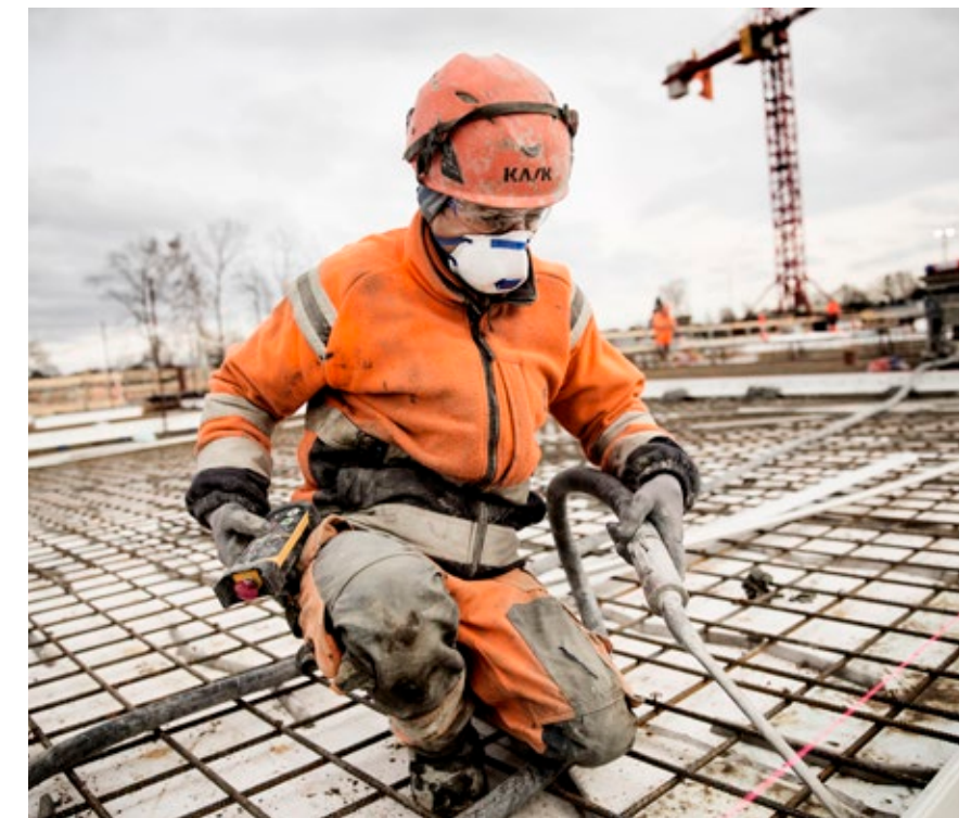
Byggeriet af letbanens kontrol- og vedligeholdelsescenter gik for alvor i gang i 2019. Bygningen forventes at stå færdig i 2021, og hele området forventes klar til brug i slutningen af 2023. Foto: Ditte Valente
