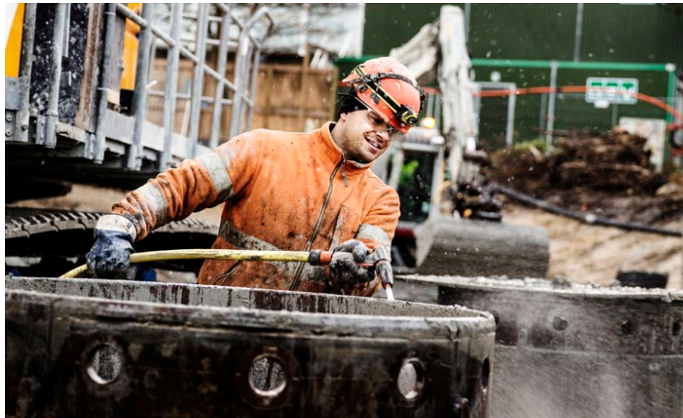
På Lyngby Station fyldte byggeriet af to nye tunneller under sporene meget i 2019. Foto: Ditte Valente
