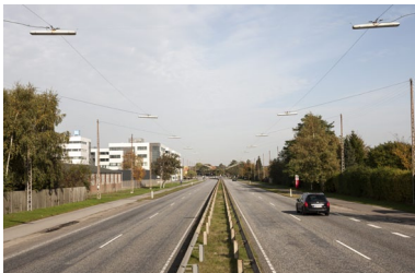
Foto fra Ring 3 nær den fremtidige station ved Lyskær
