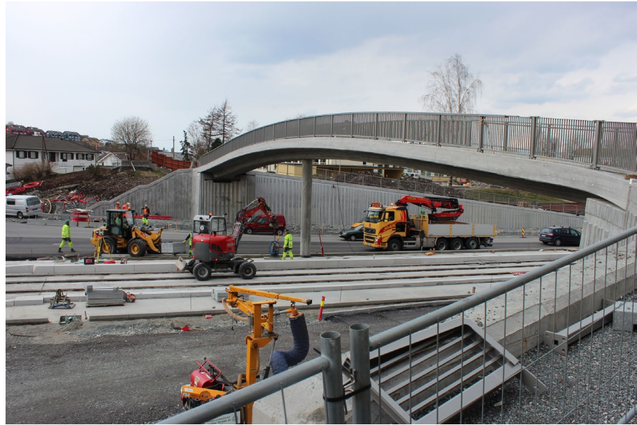
Billedet viser anlægsarbejder i forbindelse med udbygning af Bybanen i Bergen
