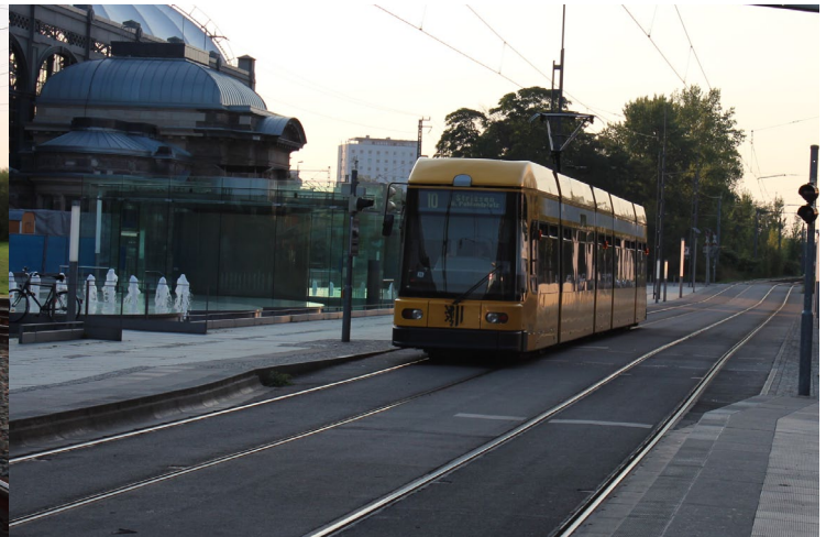
Eksempel på rilleskinnespor, som anvendes i vejkryds og ved overgange for cyklister og gående. Derudover anvendes rillespor på to delstrækninger i Lyngby, hvor letbanen kører i blandet trafik
